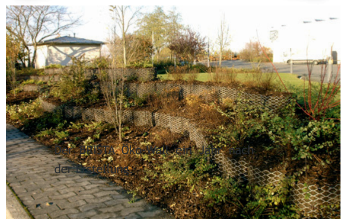
Der BRISTA Öko-Wall ein Jahr nach der Erstellung.
